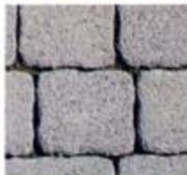
Aprókavicsos fugás kőburkolat
